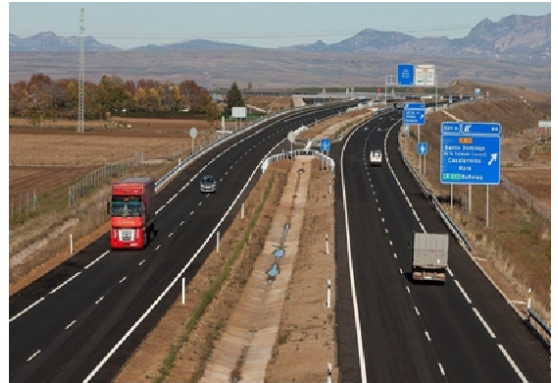
Mejora de infraestructuras
